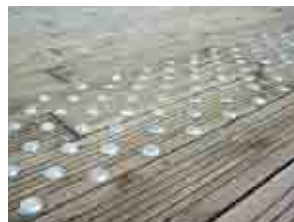
Rampa con pavimento antideslizante para acceso a la playa. Botones pododáctiles de señalización incorporados al pavimento de madera.
