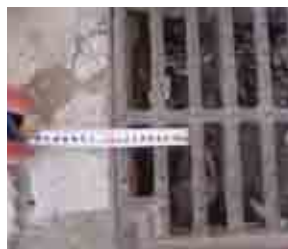
Figuras 23 y 24. Otros elementos obstaculizadores. Rejillas de sumideros con aberturas excesivas y bolardos que dificultan el acceso desde las calles transversales al paseo.
