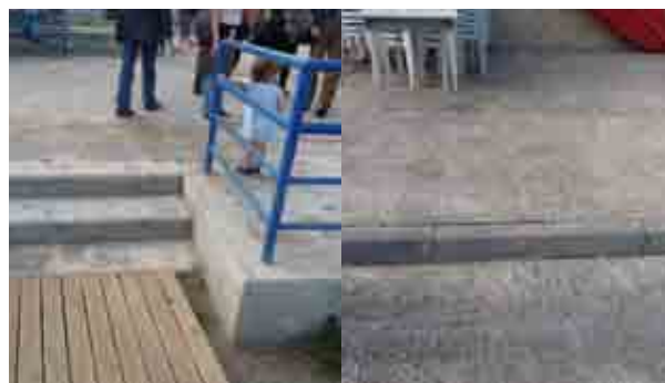
Fig. 14. Falta de pavimentos señalizadores y de orientación
