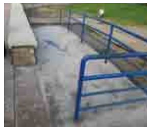
Figuras 19 y 20. Pavimento de hormigón in situ en rampas y espigones.
