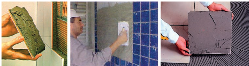
Colocación en capa gruesa.
