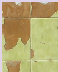
Ejemplos de alteraciones: degradación del esmalte, eflorescencias en superficie y desprendimientos.
