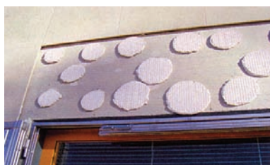
Colocación por puntos.
