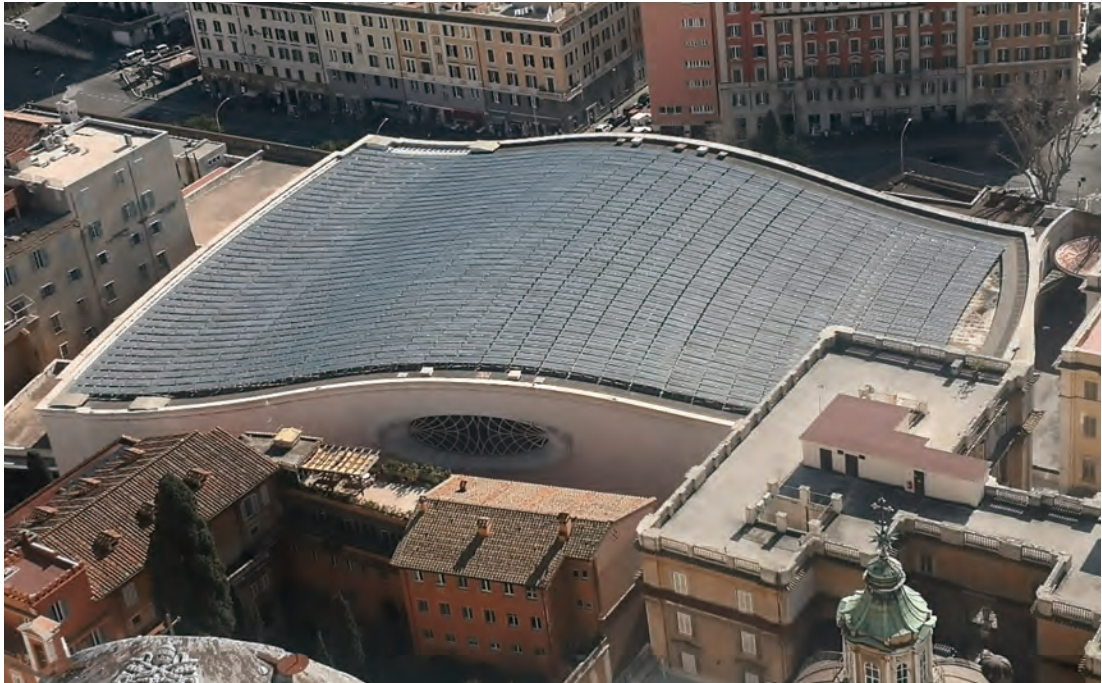
Figura 2. Pabellón Nervi en Ciudad del Vaticano convertido en centro de producción de energía solar. Fuente: Antonio Antequera
