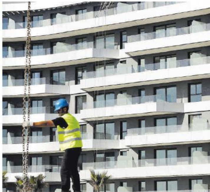
Obras de una promoción de viviendas en Málaga capital.
